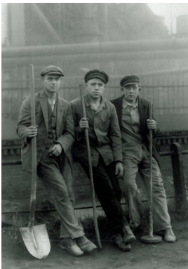
5) Straßenarbeiter im Ruhrgebiet, um 1928
