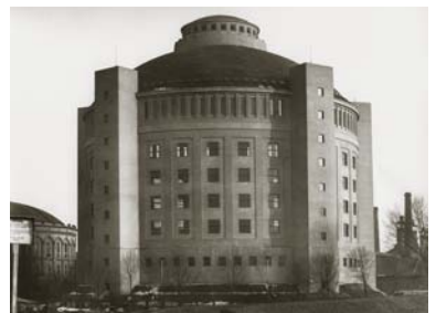
18) Die Gasanstalt in Reick, Gasometer, um 1910 (Tafel 171)
