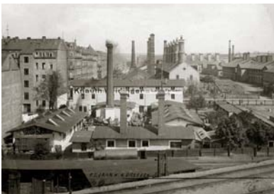
17) Die Gasanstalt, von den Hochbahngleisen an der Löbnitzstraße aus aufgenommen, undatiert [um 1900] (Tafel 167)
