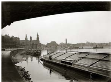
1) Blick unter einem Bogen der Carolabrücke hindurch auf die Dresdner Altstadt, 1911. Photo: Hermann Hantzsch (Tafel 4)
