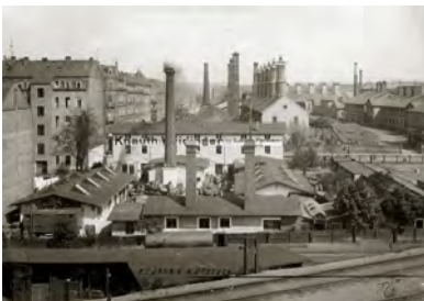
17) Die Gasanstalt, von den Hochbahngleisen an der Löbnitzstraße aus aufgenommen, undatiert [um 1900] (Tafel 167)
